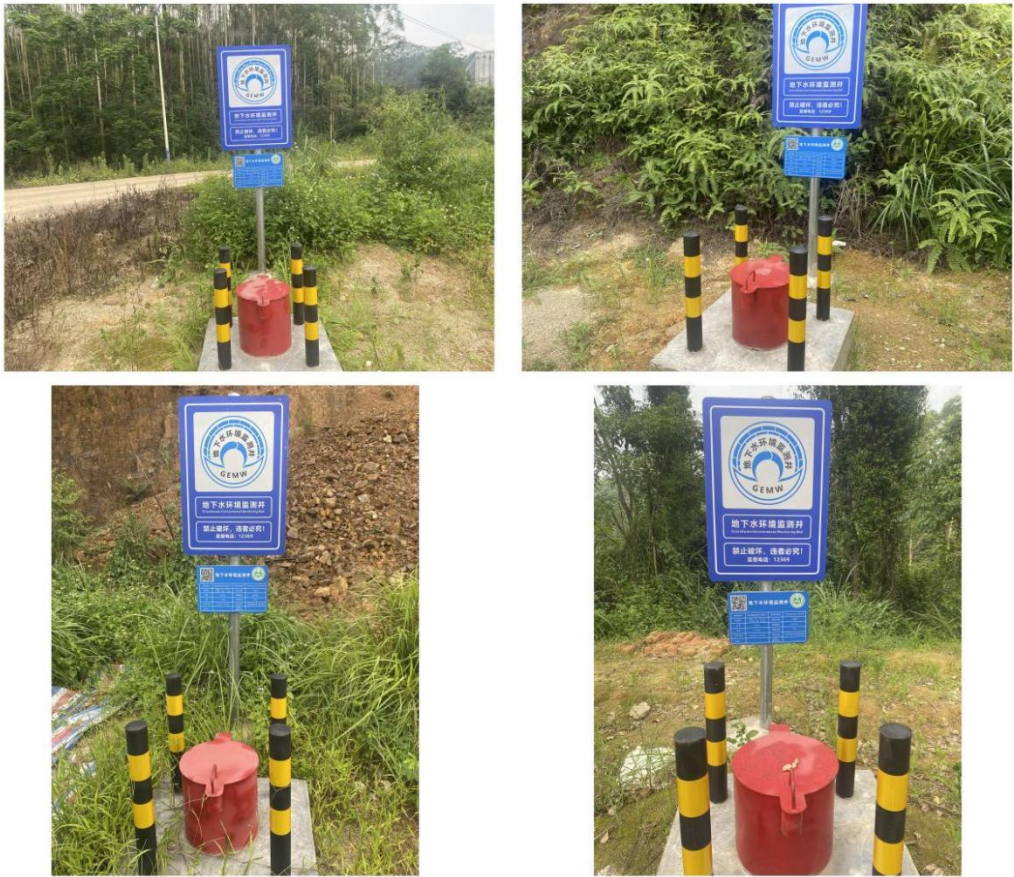
图 5.5-1 2023 年 11 月新建地下水监测井图
