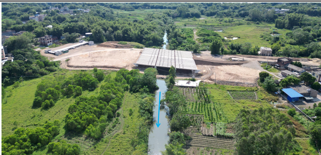
旱河跨河处现状
