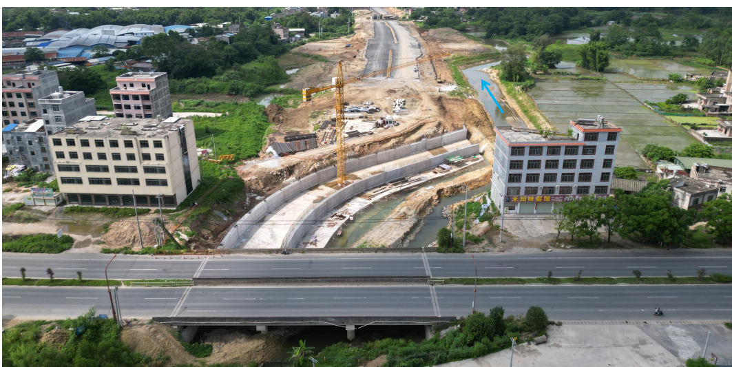
南流江跨河处现状
