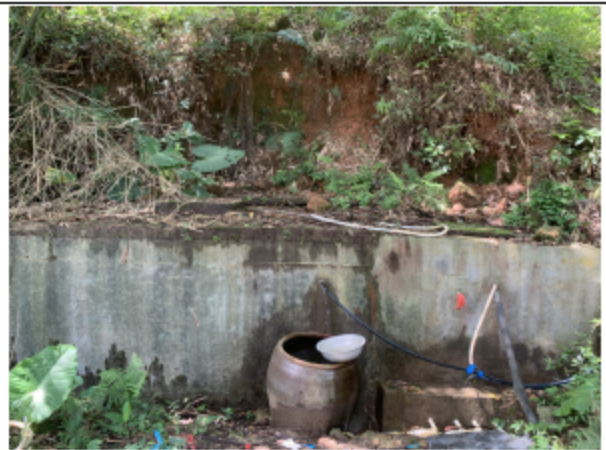
暗深塘，现场照片
